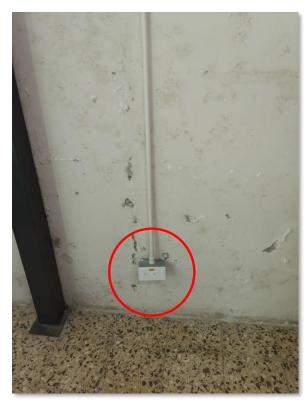
El agua que se desliza por las paredes podría pasar por los tomacorrientes, según lo indicado por el personal del Establecimiento, lo cual aumenta el riesgo de un problema mayor por un corto circuito, descarga eléctrica y por incendio.
